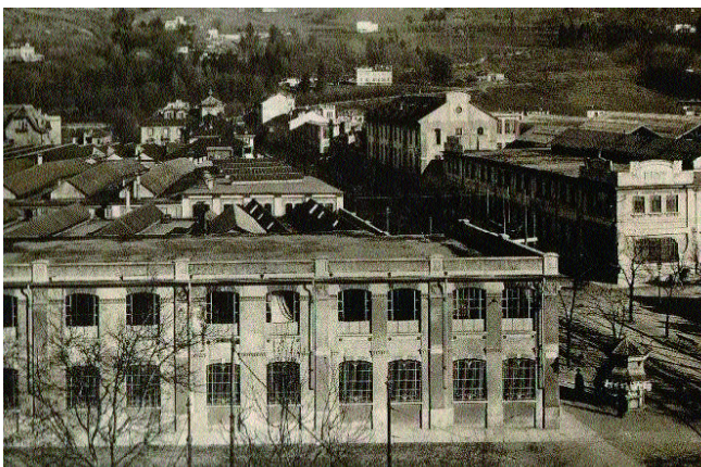
Stabilimento FIAT corso Dante
