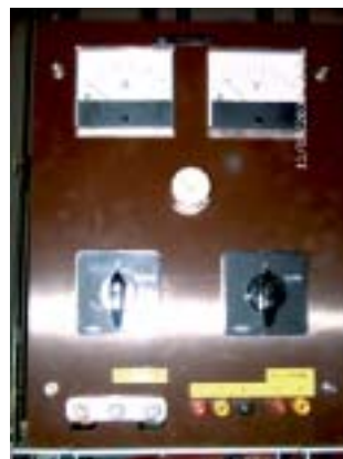
Pannello di un drenaggio unidirezionale.
