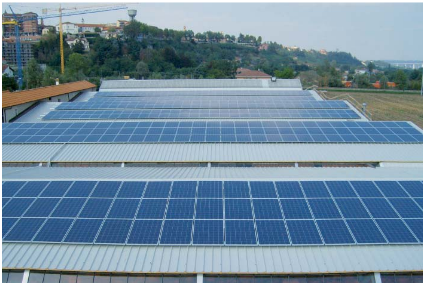
Fossano (CN) - 98,56 kWp - Impianto integrato sulla copertura, con previo smaltimento amianto.
